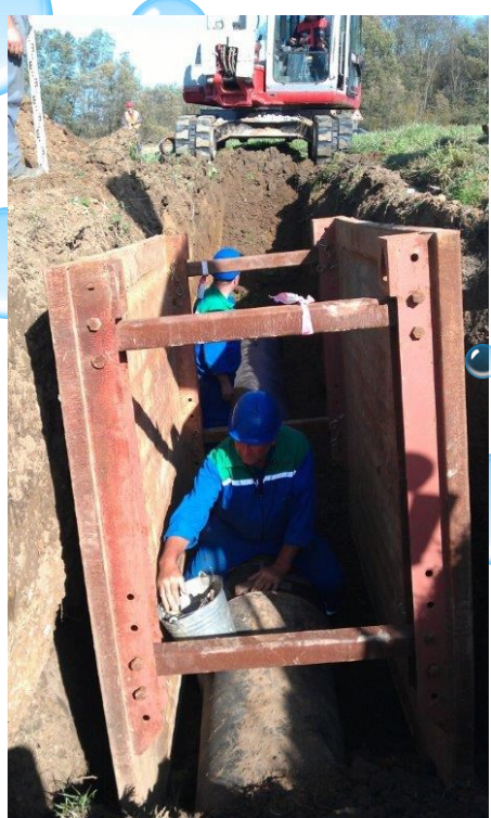
Vgradnja cevododa - Pomurje sklop B
