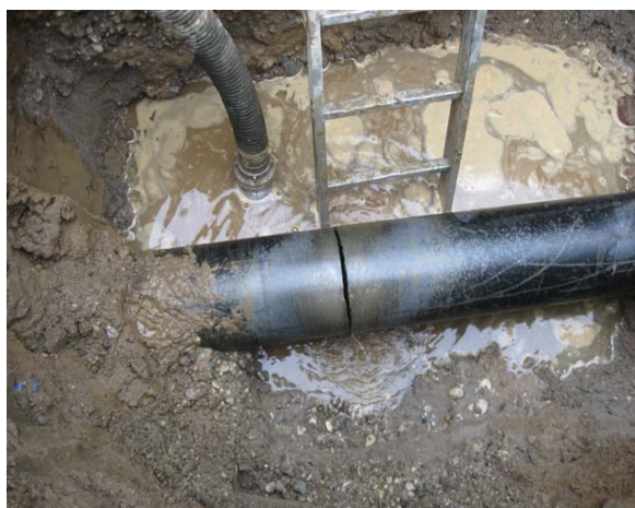
Popravilo napake na cevovodu LTŽ duktil dn 250 na Novi Zrkovski cesti
