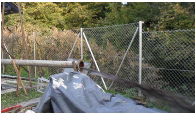
Slika 3: Nalivalni vodnjak N-2 po ščetkanju - iztekala je zelo umazana voda
