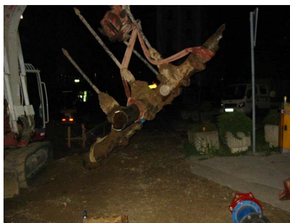
Nočna akcija na Ulici kneza Koclja – staro križišče LTŽ dn 350 z odcepom pod Titovim mostom
