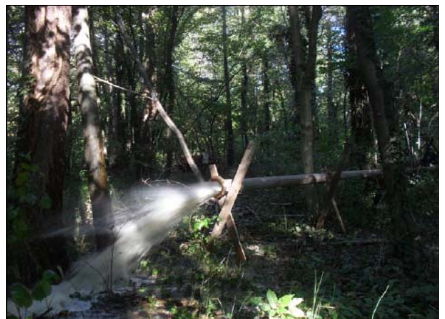
Slika 2: Vodnjak V-3 po kemično-mehanski revitalizaciji
