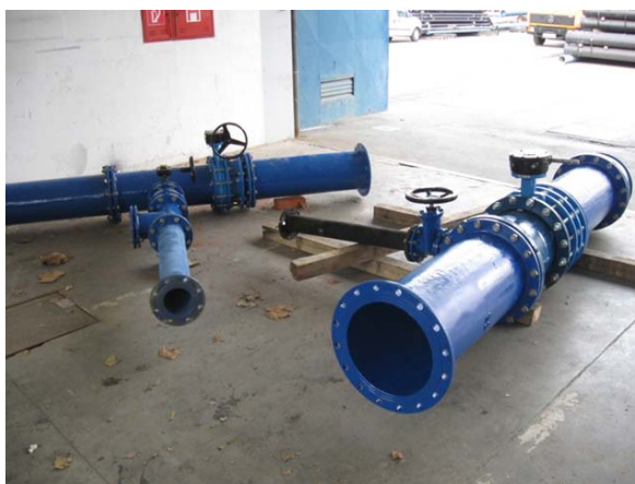
Montaža elementov dn 400 z odcepi za dva jaška – objekt Zamarkova SV Slovenija
