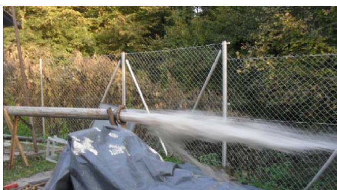
Slika 4: Nalivalni vodnjak N-2 po kemično mehanski revitalizaciji
