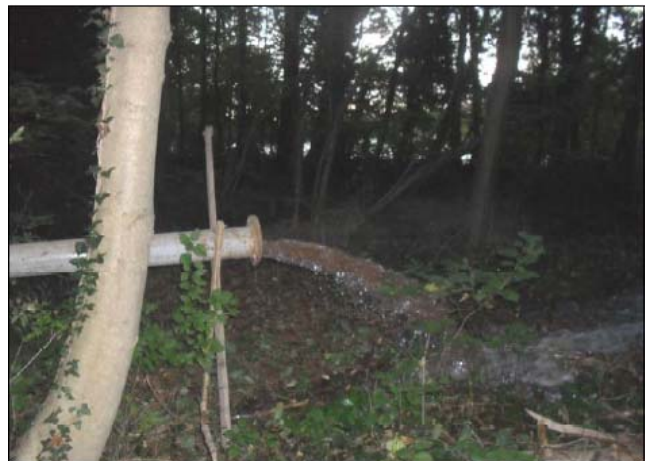
Slika 1: Vodnjak V-3 po ščetkanju - iztekala je zelo umazana voda
