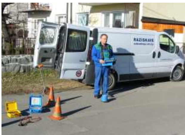
Slika: Iskanje napake na vodovodnem omrežju
