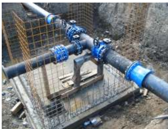
Slika: Montaža elementov v jašek na obvoznici v Zrkovcih
